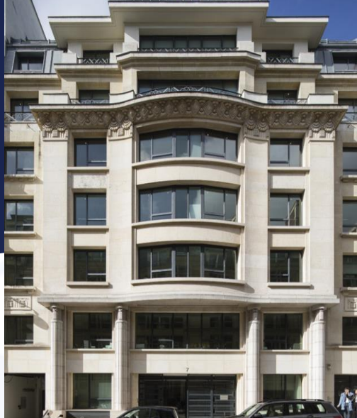
7 rue de Téhéran, Paris 8 ème (immeuble de bureaux)
